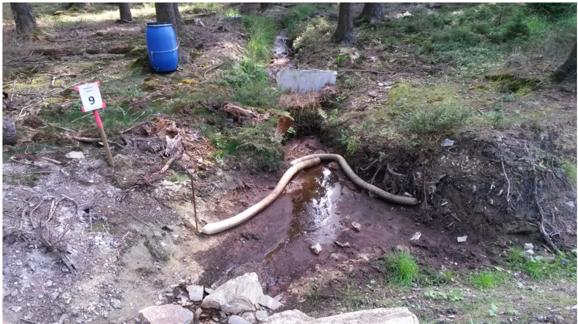
Abbildung 6: Sedimentsperre und Strömungsbarriere mit vorsorglich eingebautem Sorb-Schlängel zum Ölrückhalt – aufschwimmfähige Befestigung mittels Schnurnagel
