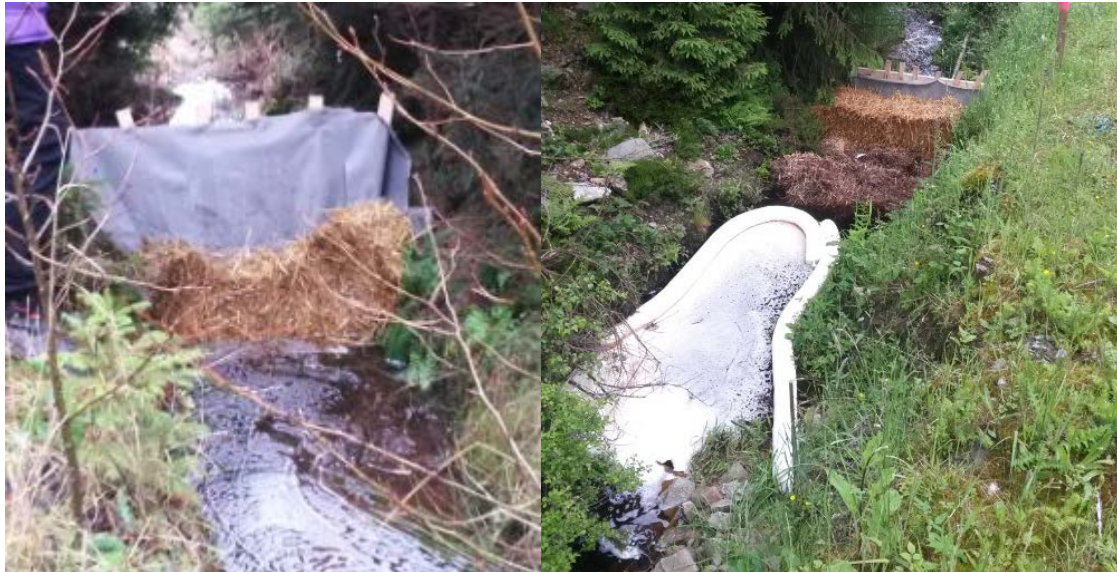
Abbildung 5: Sedimentsperre und Strömungsbarriere zum Rückhalten von absetzbaren Stoffen und zum vorsorglichen Einbau von Sorb-Schlängeln
