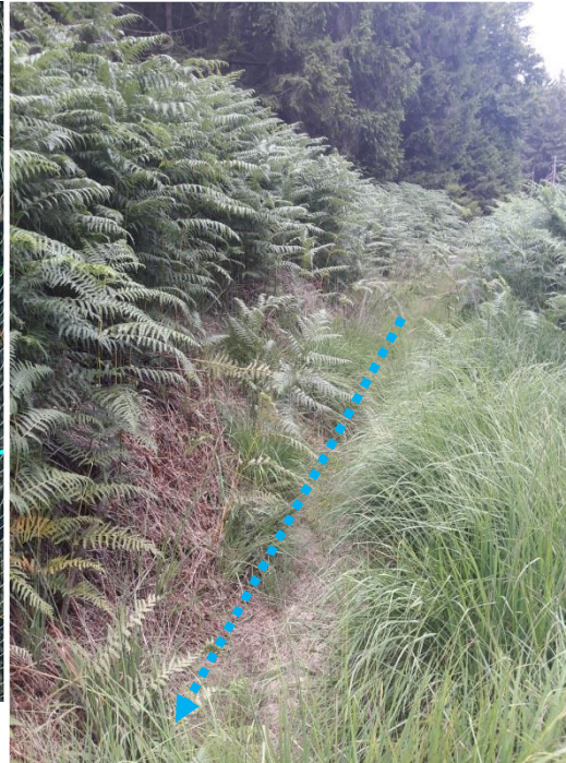
Entwässerungsgraben Fließrichtung Westen, Entwässerung zur südwestlich gelegenen Freifläche (bultige Wiese), Blickrichtung Osten
