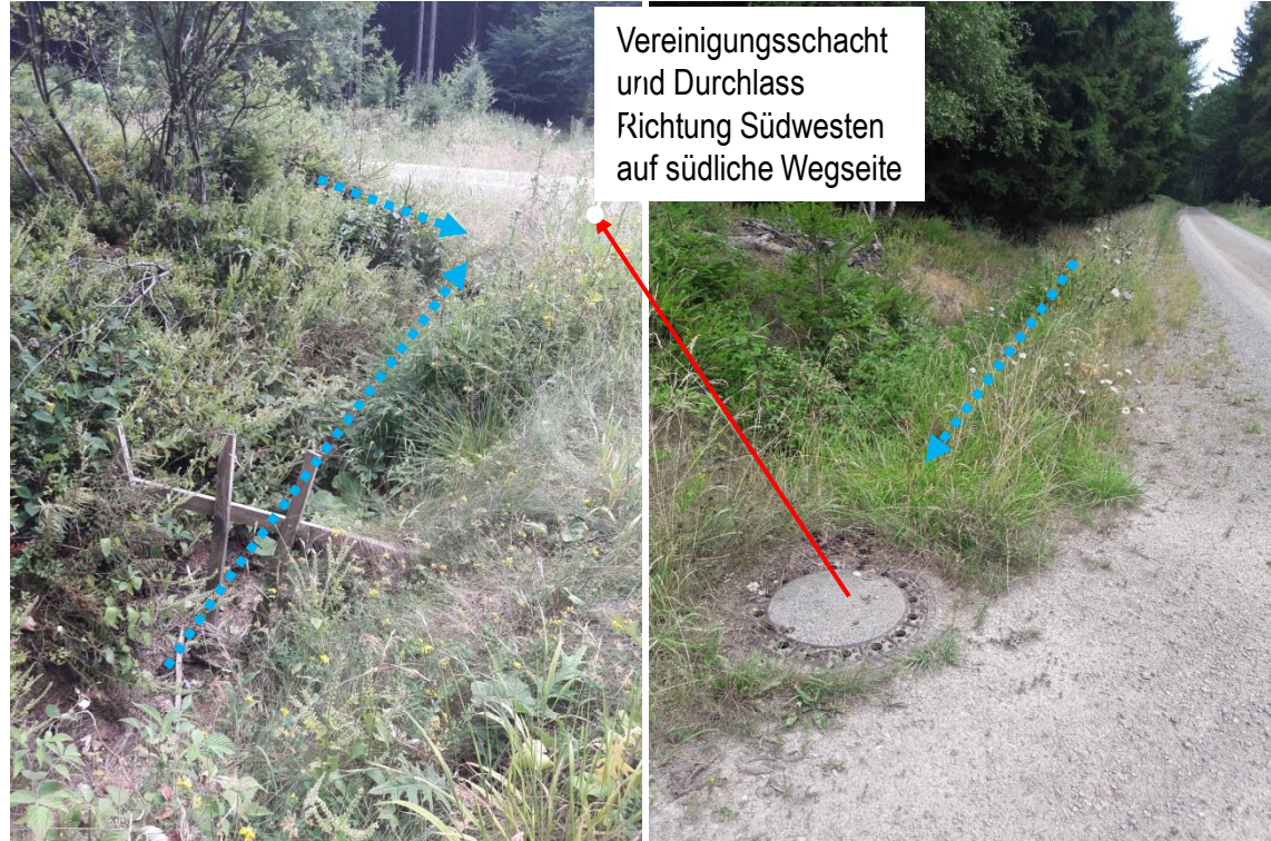
Wegrandgraben mit Holzrechen (ehem. Sedimentsperre), Blickrichtung Süden
