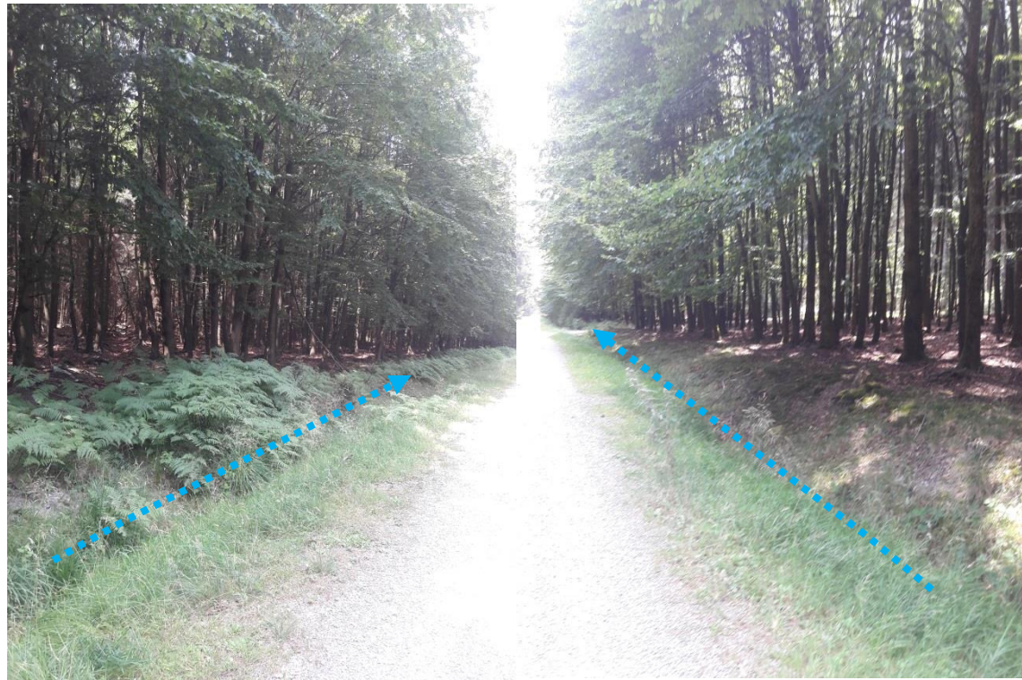
Entwässerung erfolgt auf beiden Straßenseiten im Wegrandgraben, Fließrichtung Süden, Blickrichtung Süden, während der Begehung am 25.07.2019 trocken
